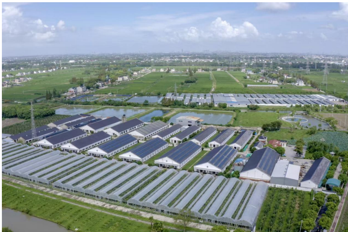
图：东林村羊场光伏项目。
