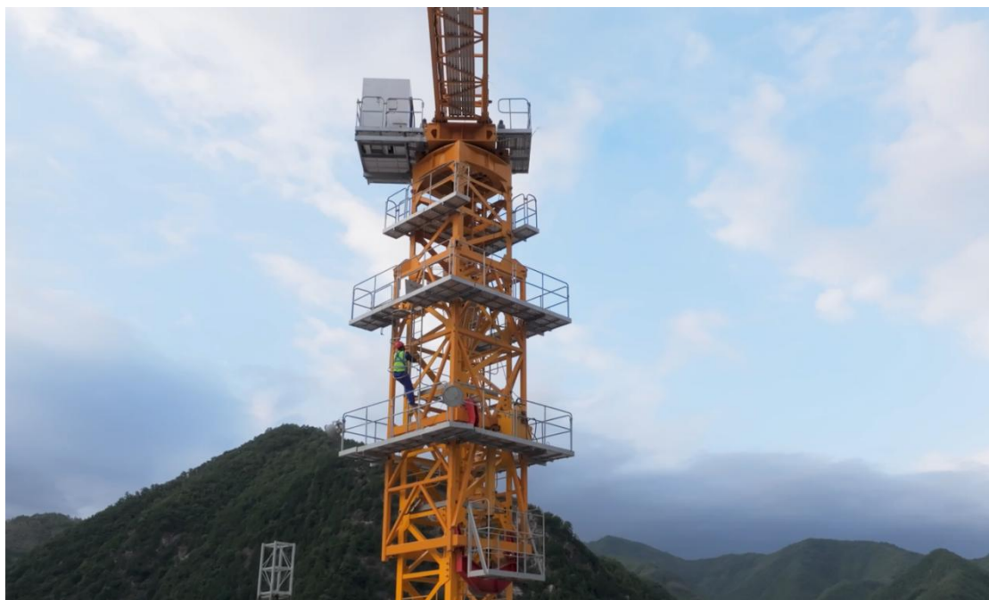
图：正在爬塔的塔吊司机
