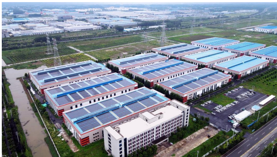
图：江苏金发再生资源有限公司厂区
